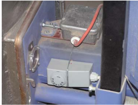
6. 8. kép. A visszaégésgátlás első fokozata. A felhelyezett csőtermosztát.
