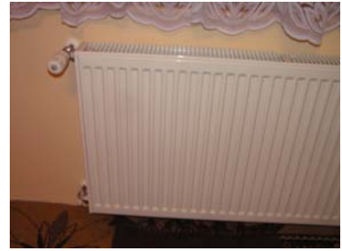
IV. 16. kép. Radiátor termosztátos radiátorszeleppel.
