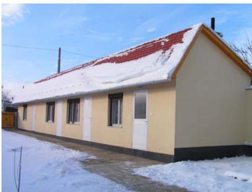
IV. 19. kép. Melléképületben a szigetelt és a nem szigetelt tetővel rendelkező rész jól látható.
